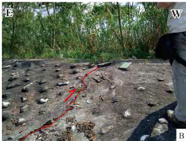
圖五、A：東里阿眉溪橋地表破裂位置圖。B：阿眉溪橋地表破裂逆衝破裂。
