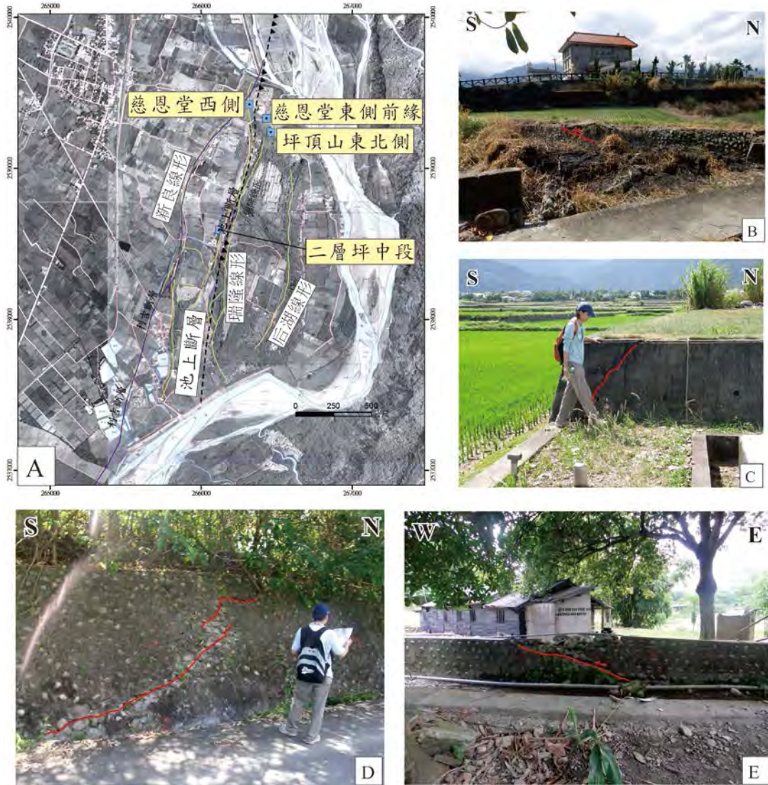
圖十二、A：瑞源地區地表破裂位置圖。B：慈恩堂東側溝渠逆衝破裂。C：慈恩堂西側圍牆破裂。D：坪頂山東北側護牆破裂。E：二層坪中段溝渠逆衝破裂。
